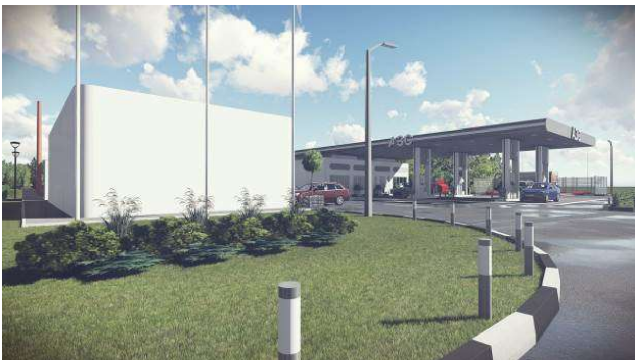
Скрытие фундаментов и крепежных элементов информационных конструкций и флажштоков
